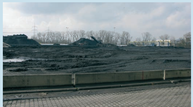
Der geplante Standort des Neubaus – auf dem ehemaligen Kohlelagerplatz.
